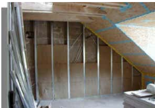
Einbau der Dämmstoffe
