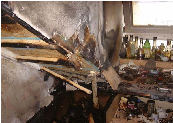
Nach dem Brand: die Fenster sind von der Hitze geschmolzen, die Dachkonstruktion hat gehalten!
