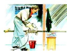
Besser ist es allerdings, für das Auftauen Haartrockner, Heizlüfter, Heißluftgebläse, Dampfstrahlgerät oder Tücher, die in heißes Wasser getaucht werden, zu verwenden.
