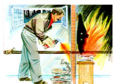
Auftauarbeiten von eingefrorenen Wasserleitungen sollten grundsätzlich auch nicht mit elektrischem Strom durchgeführt werden, auch nicht aus einem Auftau- oder Schweißtrafo, einem Umformer oder Gleichrichter.
